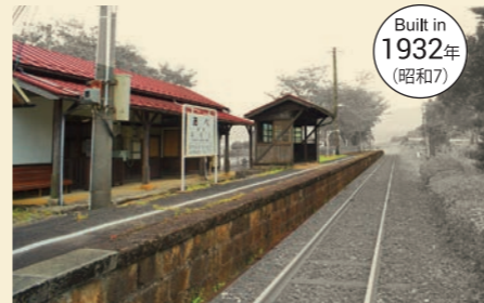
5 安部駅プラットフォーム Abe Station Platform
