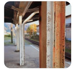
丹比駅プラットフォーム (カーネギー製支柱) Tampi Station Platform (Pillar made by Carnegie)
