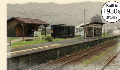
7 八東駅プラットフォーム Hatto Station Platform
